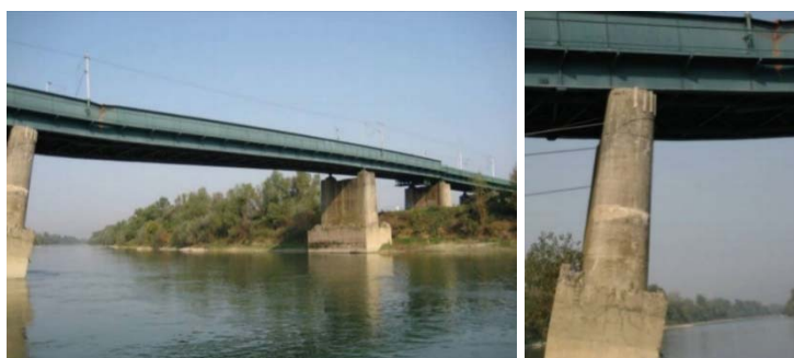
Slika 3. Most „Sava – Jakuševac“ nakon gubitka stabilnosti [16]
