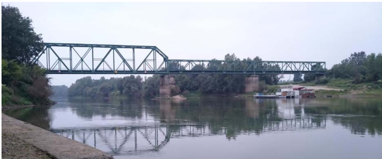
Slika 14. Most Sava – Jasenovac, pogled uzvodno [29]
