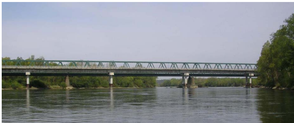
Slika 11. Most Drava – Botovo, pogled uzvodno [26]
