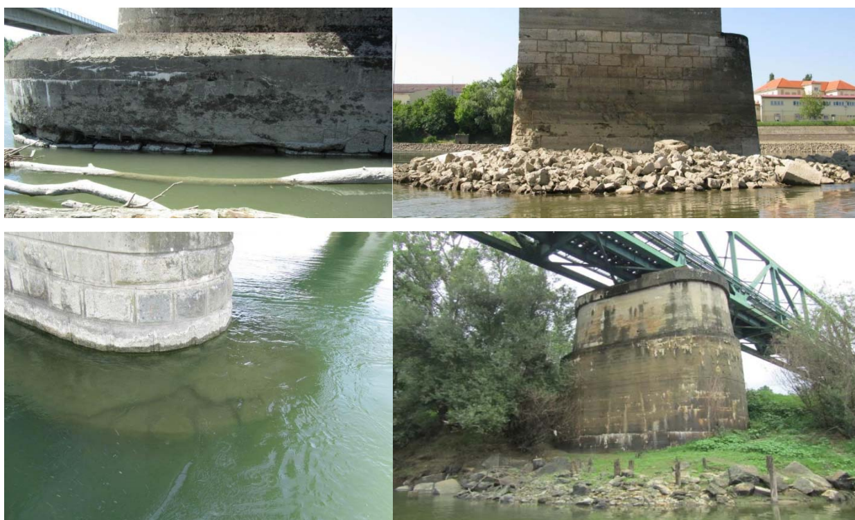
Slika 17. Lijeva strana stupa S1 mosta Botovo (gore lijevo), oštećenje u lijevom uglu stupa S1 na mostu Osijek (gore desno), oštećenje na stupu S4 mosta Varaždin (dolje lijevo), urušena obaloutvrda na mostu Jasenovac (dolje desno) [26, 27, 28, 29]
