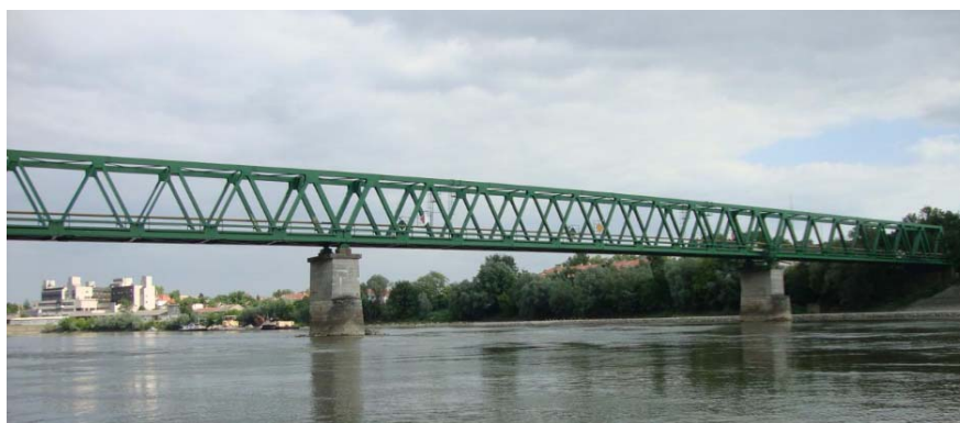
Slika 12. Most Drava – Osijek, pogled nizvodno [27]
