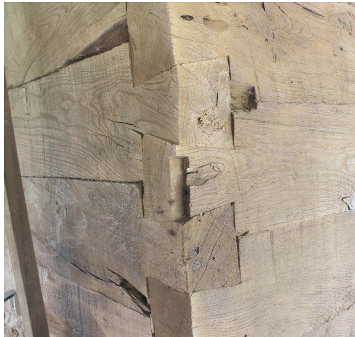
Slika 30. Njemački sjek na novom objektu
