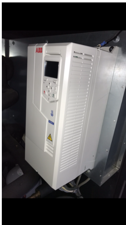
Slika 10: Ugrađeni frekvencijski pretvarač ABB ACH580-01
