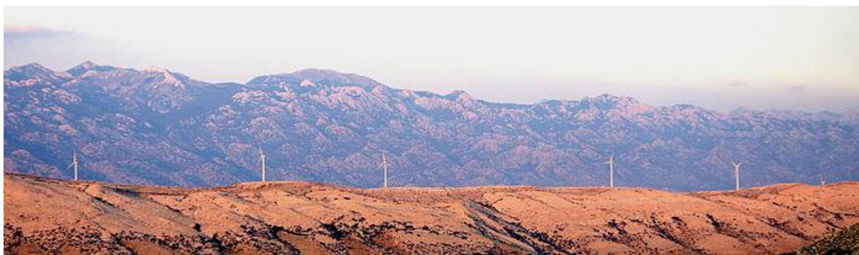
Slika 22. Šest od sedam vjetroagregata iz sustava Vjetroelektrane Ravne 1 na Pagu [7]
