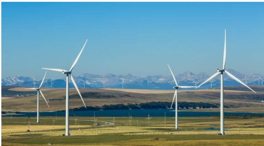
Slika 1. Primjer kopnene vjetroelektrane [1]
