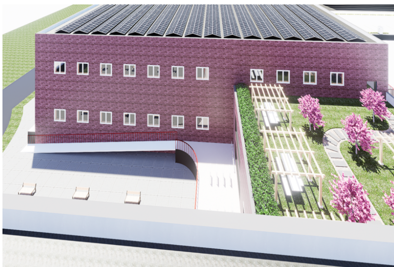
Slika 41 Unutarnja sjeverna strana zgrade
