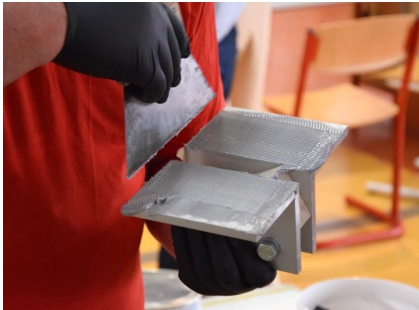
Slika 4.17 Nanošenje ljepila Sikadur 330 na aluminijski kutnik
